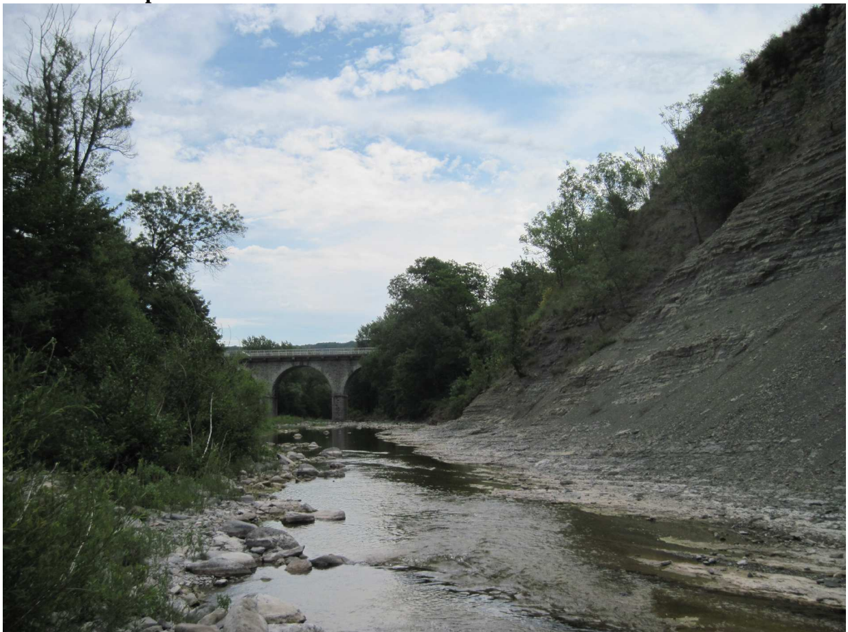
Pont de la Cave coopérative Alba
